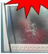
Painel elétrico com tampa Quebrada!
