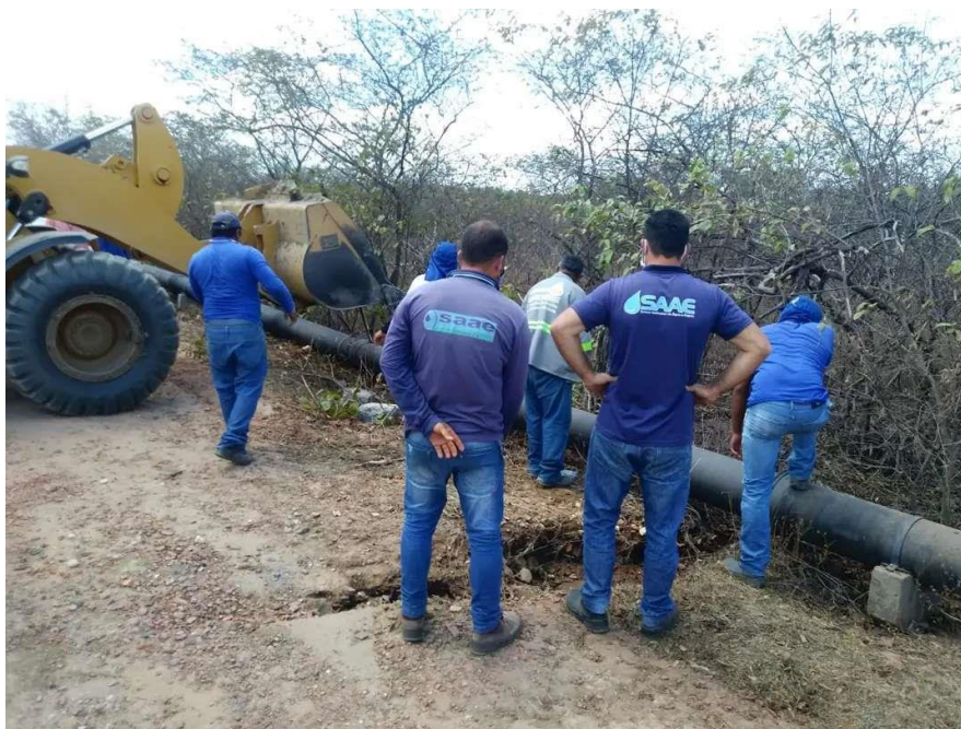
Figura 4: Adutora do açude General Sampaio.
