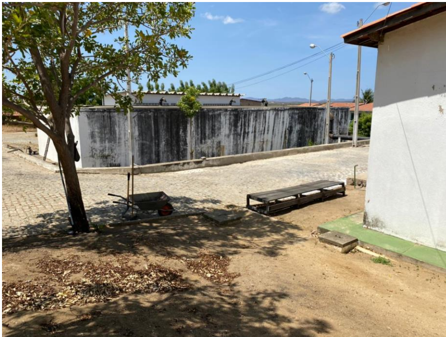
Figura 12: Reservatório de 25.000 m 3 .
