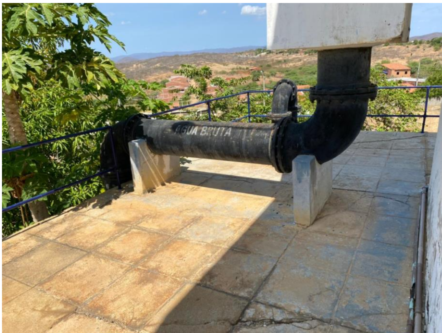
Figura 9: ETA 1 Adutora de água bruta.
