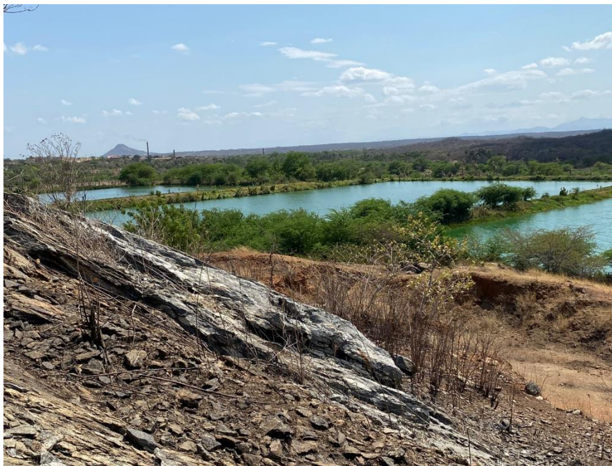
Figura 16: Lagoa de estabilização.
