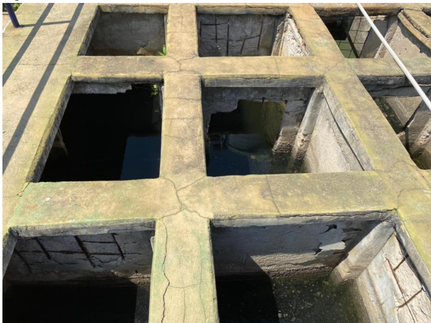
Figura 7: ETA 1 Floculador.
