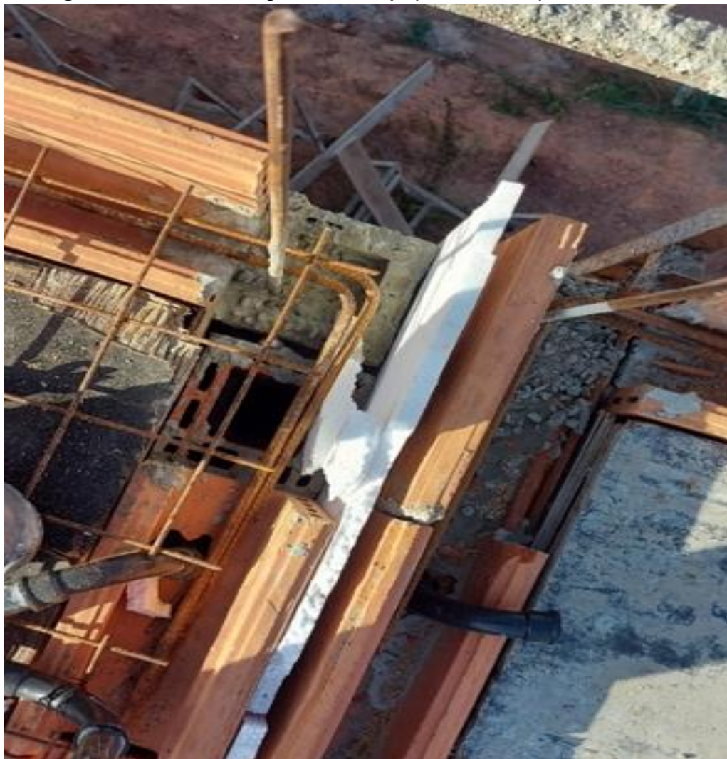
Figura 2 – Pontos de graute em laje pavimento tipo
