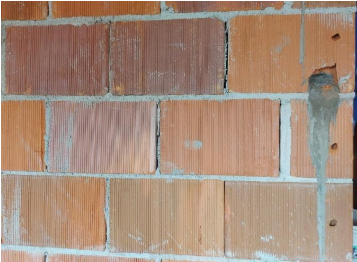
Figura 6 – Parede de alvenaria estrutural
