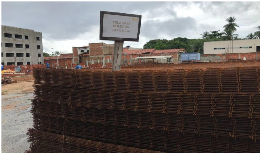
Figura 7 - Disposição das telas de aço.
