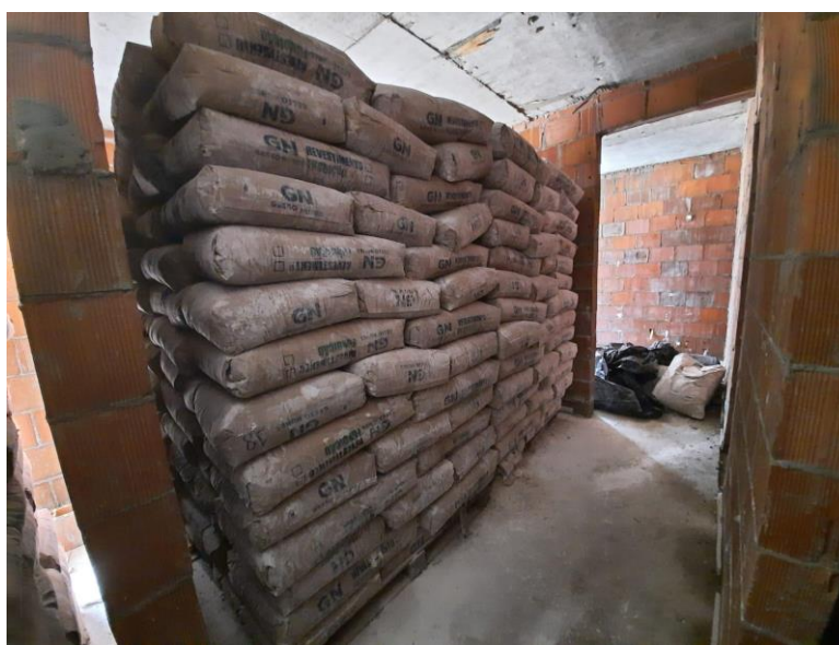
Figura 2: Gesso em sacos empilhados de forma incorreta. Fonte: próprio autor, 2022.
