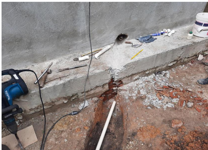
Figura 5: Escareamento de radier para passagem de tubulação. Fonte: próprio autor, 2022.
