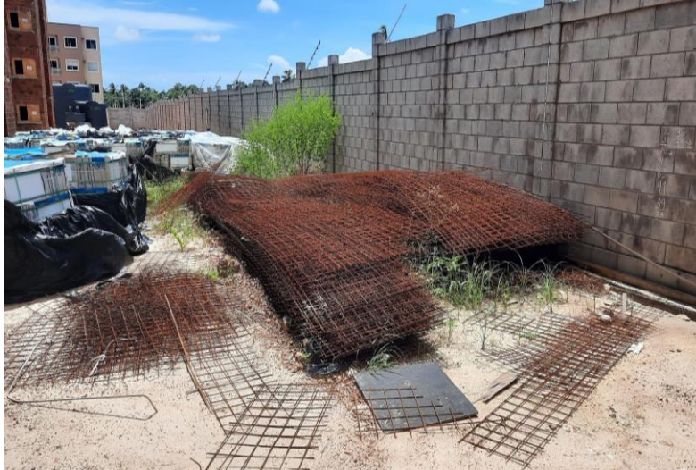
Figura 3: Telas de aço armazenadas em contato com o solo e sem proteção. Fonte: próprio autor, 2022.
