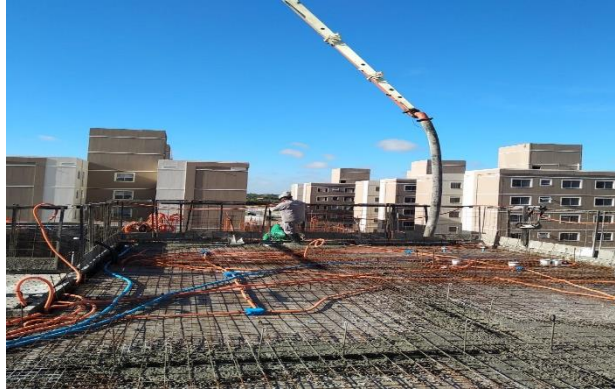
Figura 3 – Processo de lançamento do concreto (preenchimento das fôrmas)
