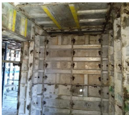
Figura 2- Vão com a forma de alumínio montada
