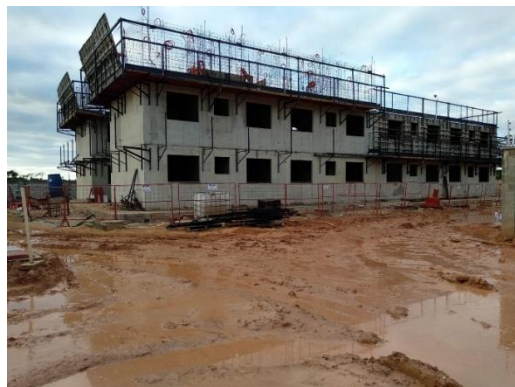
Figura 4 – Forma em processo de desforma e transferência dos andaes inferiores para superiores
