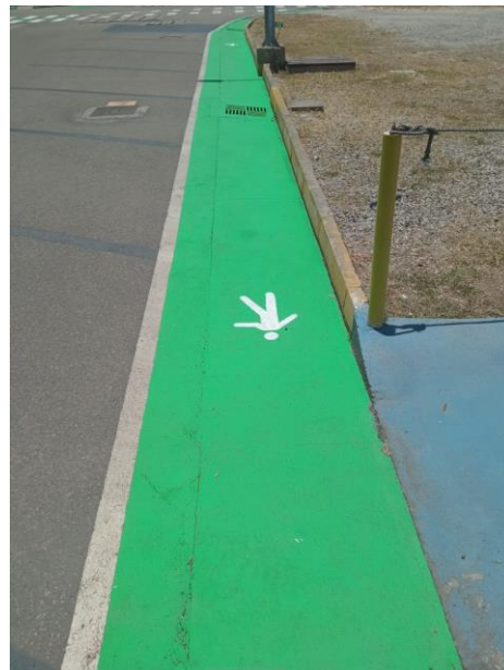
Figura 17: Sinalização de caminho seguro
