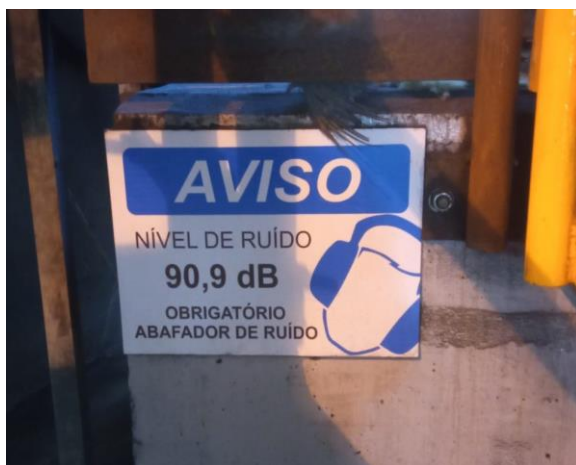
Figura 10: Sinalização de nível de ruído/caldeira
