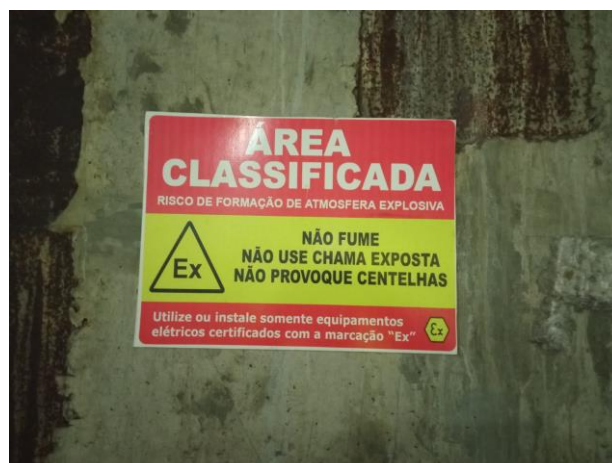
Figura 12: Sinalização de área classificada/turbina
