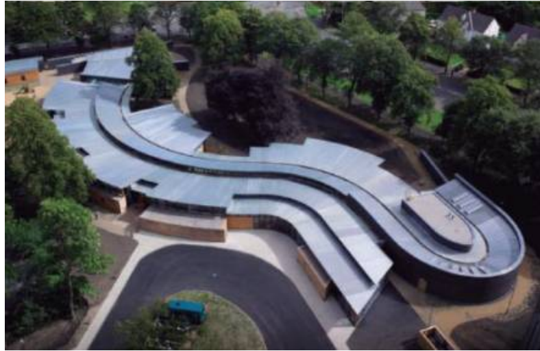
Figura 5 – Vista superior da escola, que obtém formato curvilíneo.
