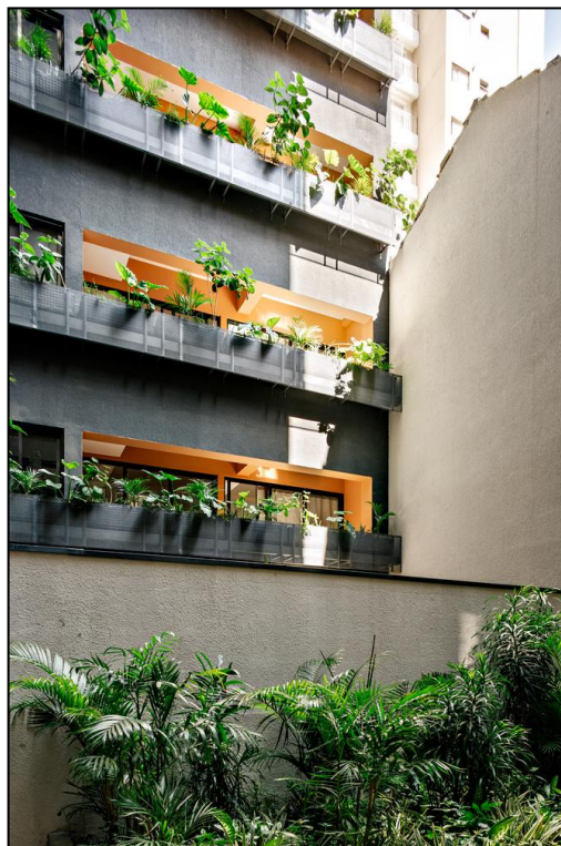
Figura 18: Sub estruturas na fachada interna do Edifício Magdalena Laura
