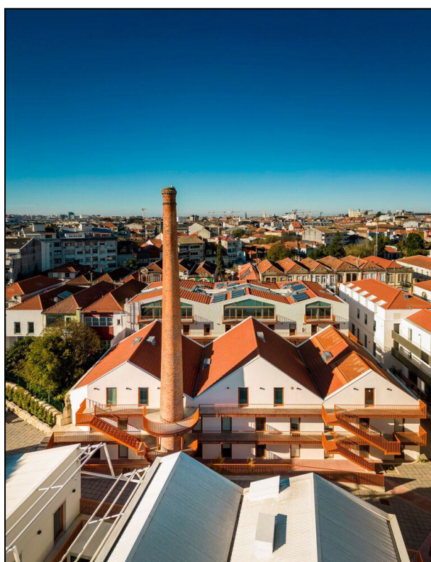
Figura 20: Vista da chaminé do Conjunto Habitacional
