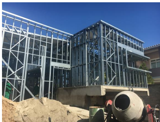
Figura 31– Estrutura da residência em LSF
