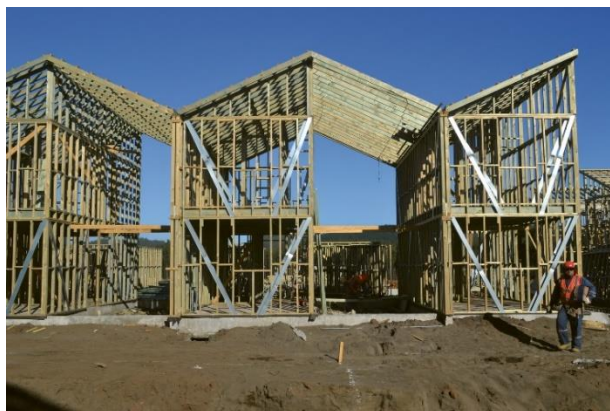
Figura 27 – Estrutura das residências em Wood Frame
