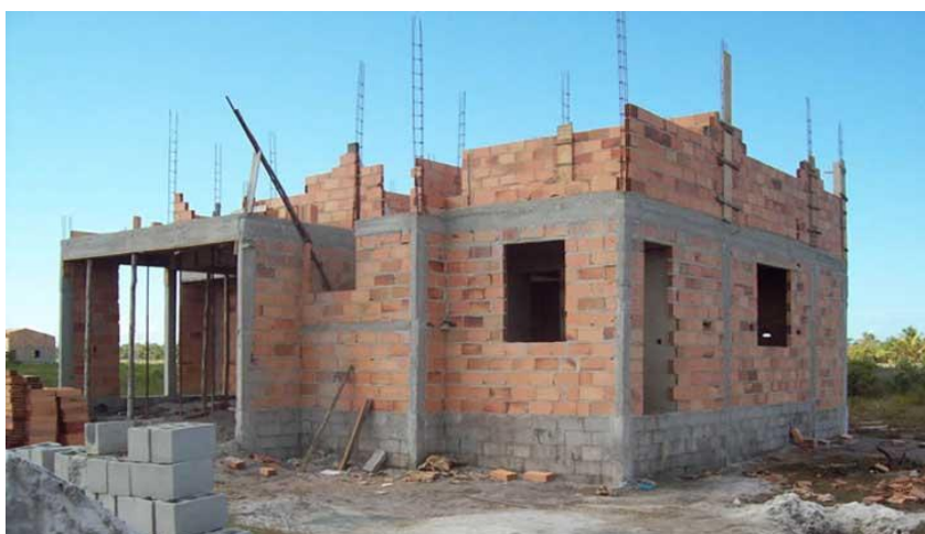
Figura 10 – Construção de alvenaria convencional com estrutura em concreto armado
