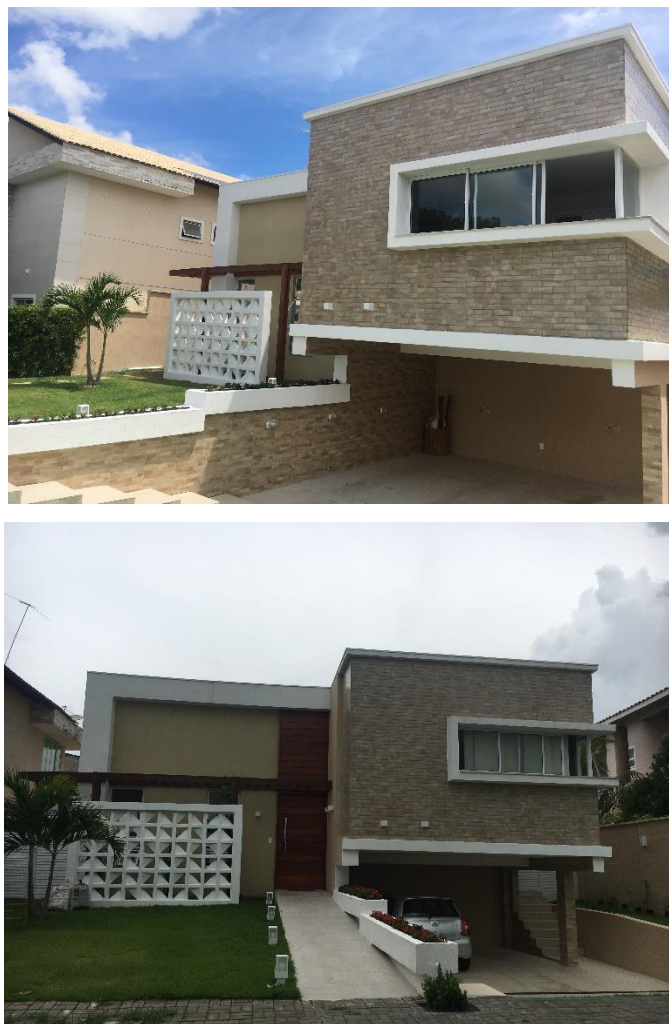
Figura 35 – Edificação em LSF finalizada
