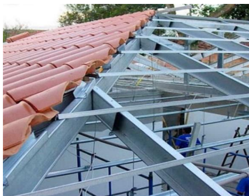
FIGURA 8 – Telhado Steel Frame
