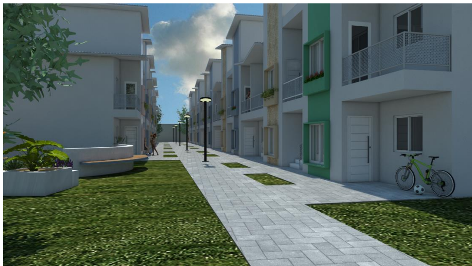
Figura 45 – Vista das edificações Quadra A
