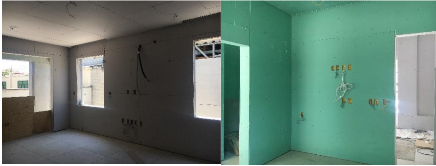
Figura 33 – Instalações elétrica e placas de gesso acartonado.
