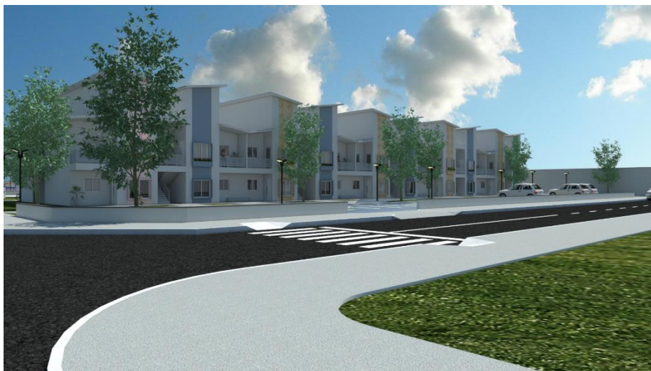
Figura 43 – Fachada Quadra A
