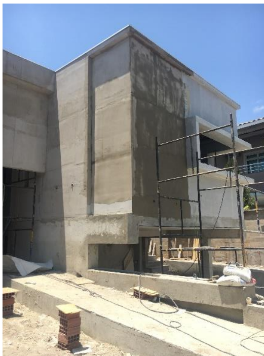
Figura 32 – Acabamento externo com placas cimentícias
