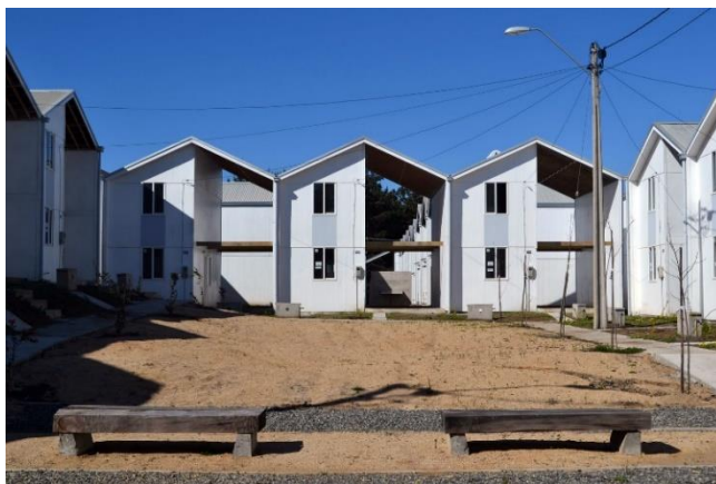
Figura 26 –Conjunto Habitacional Villa Verde
