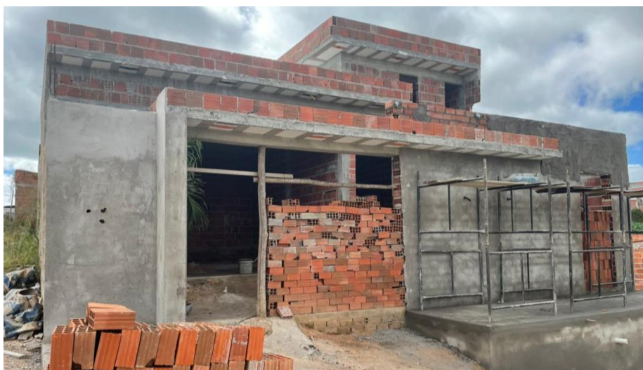
Figura 12: Empreendimento residencial, obra 2.
