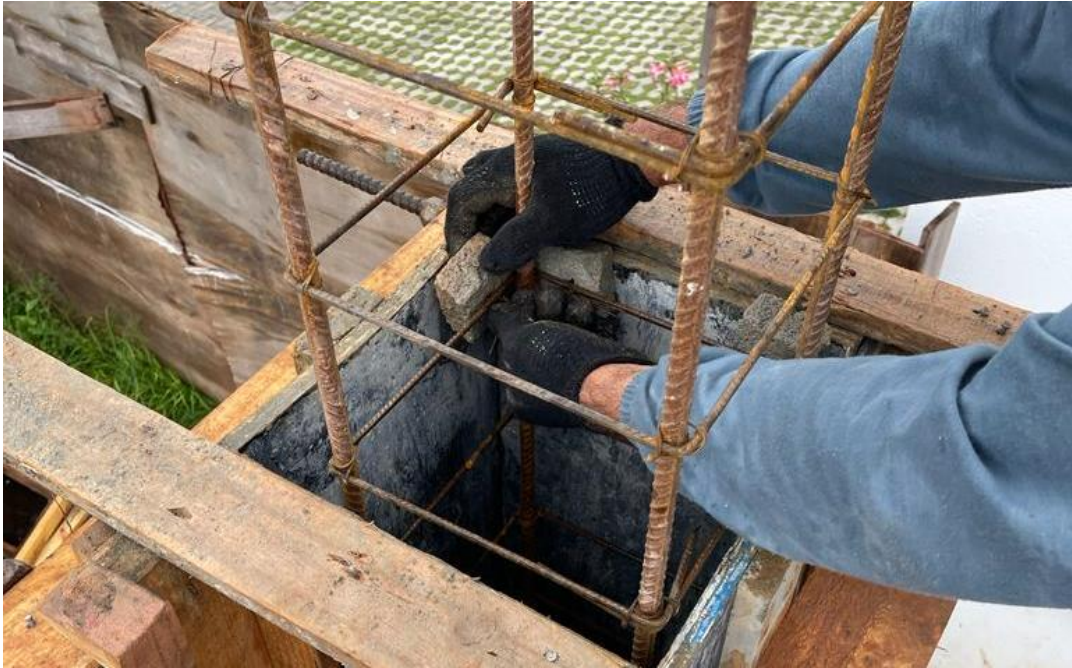
Figura 18 – Medição de cobrimento de pilar
