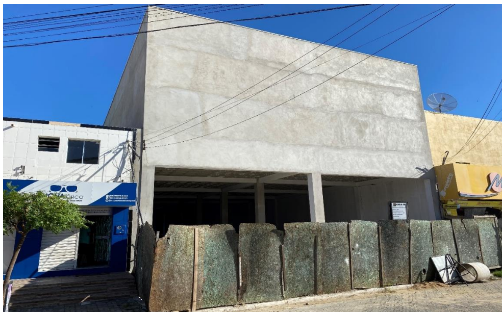
Figura 13: Empreendimento comercial, obra 3.
