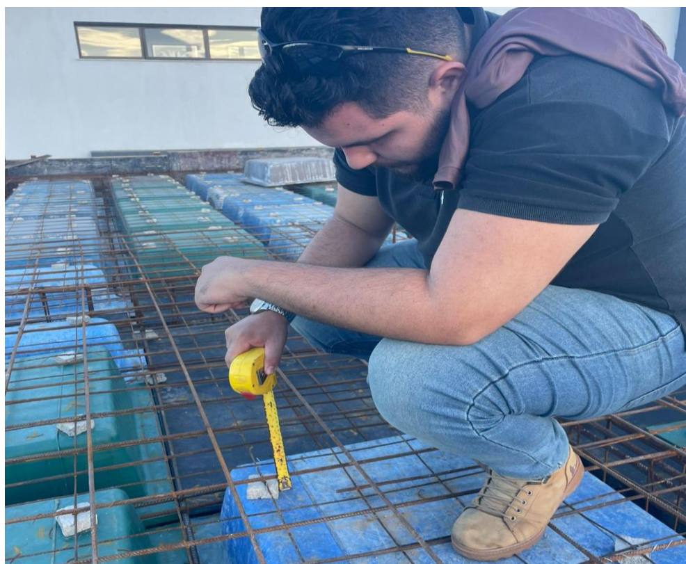
Figura 17 – Medição de cobrimento de laje
