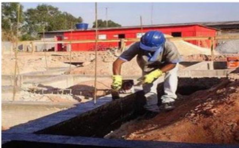
Figura 5 – Impermeabilização com emulsão asfáltica
