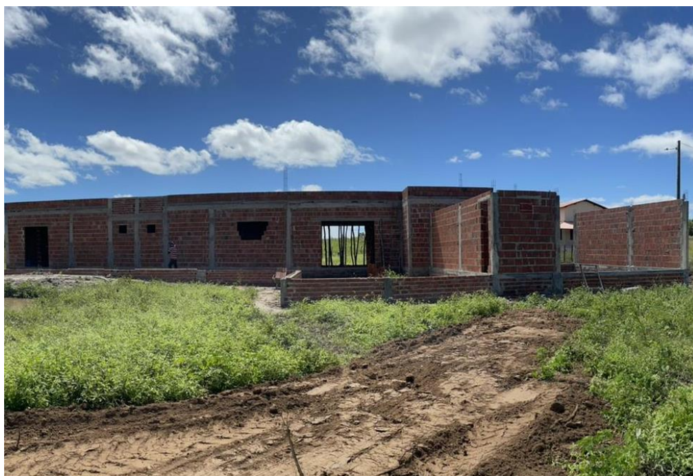
Figura 14: Empreendimento residencial, obra 4.
