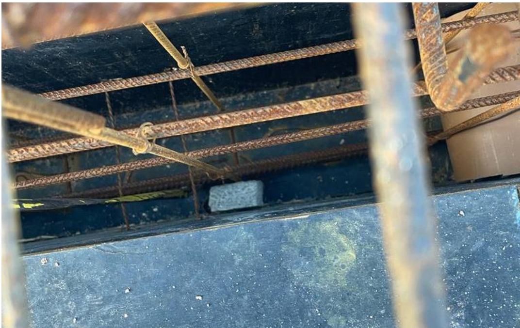
Figura 19 – Medição de cobrimento de viga
