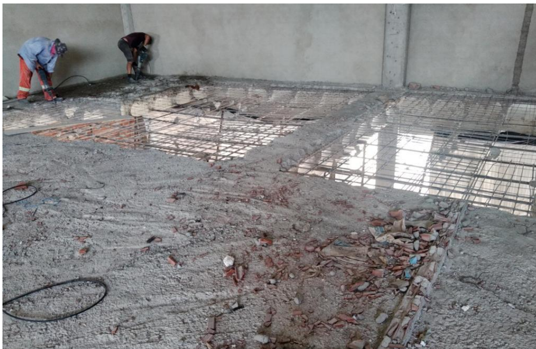
Figura 24 – Demolição da laje – Obra 3
