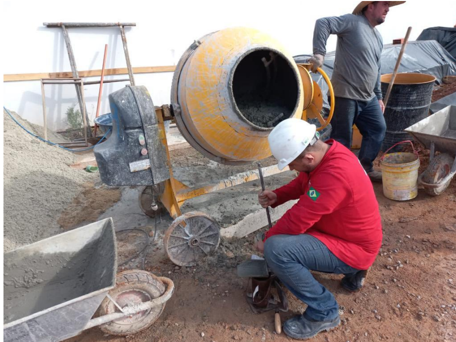
Figura 10: Concreto produzido e sendo levado para ensaio
