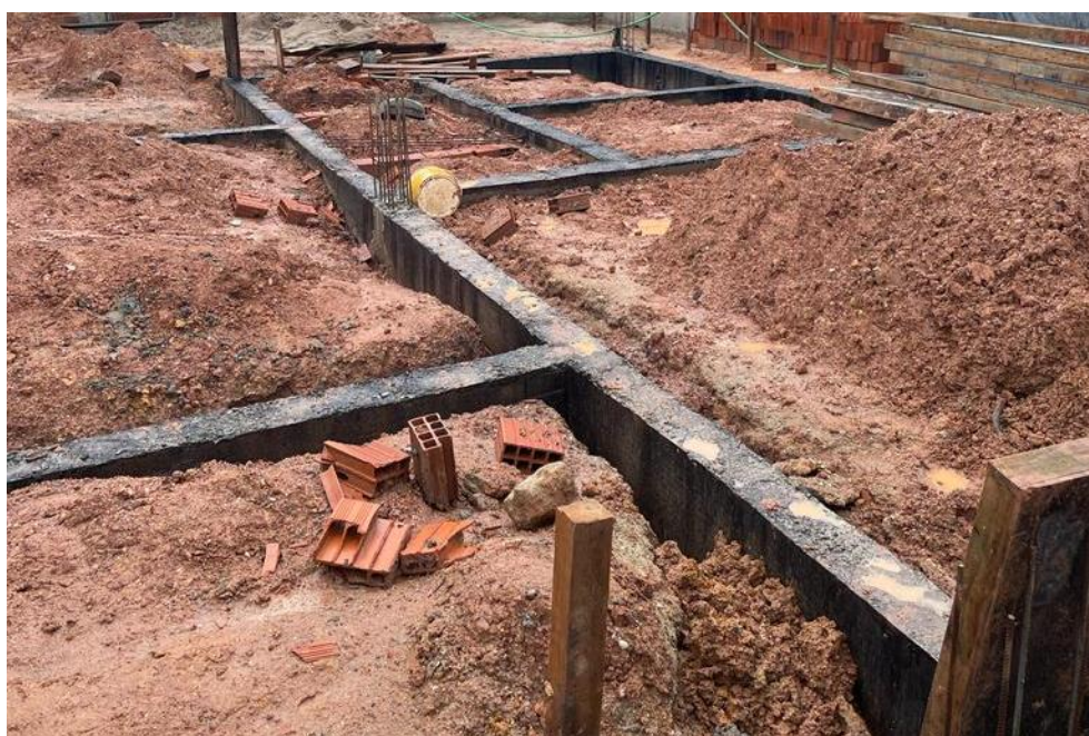
Figura 16 – Fundação impermeabilizada
