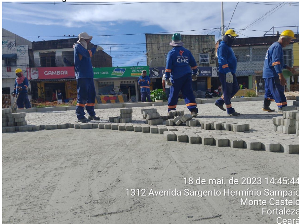
Figura 04 – Assentamento de blocos intertravados
