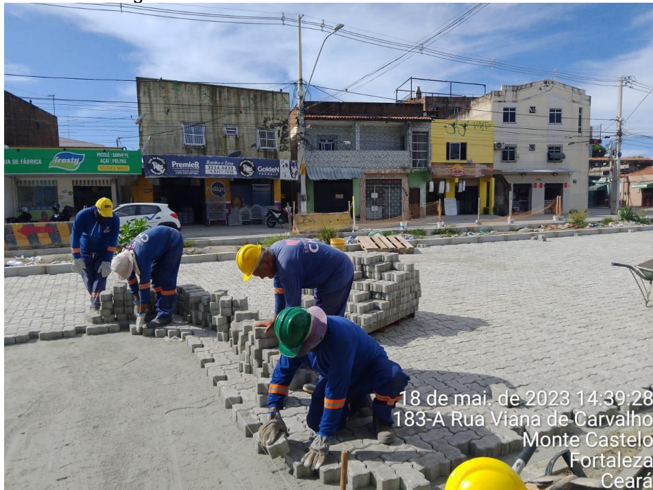
Figura 03 – Assentamento de blocos intertravados
