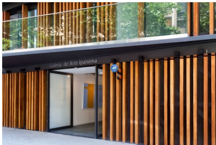
Figura 10 - Brises da Fachada Galeria da Arte Ipanema.
