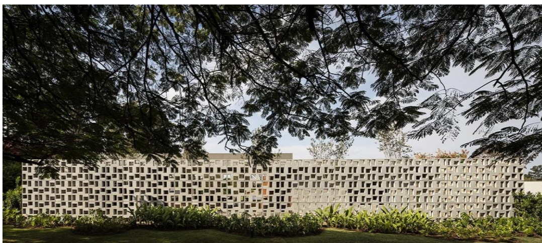
Figura 03: Utilização da parede oca de tijolos como elemento de divisória da área verde para casa
