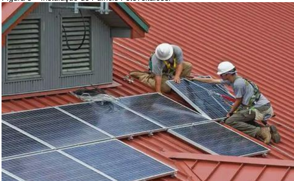
Figura 5 – Instalação de Painéis Fotovoltaicos.
