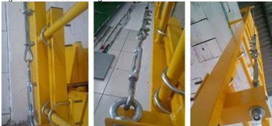
Figura 6 – Linha de Vida Rígida Vertical.
