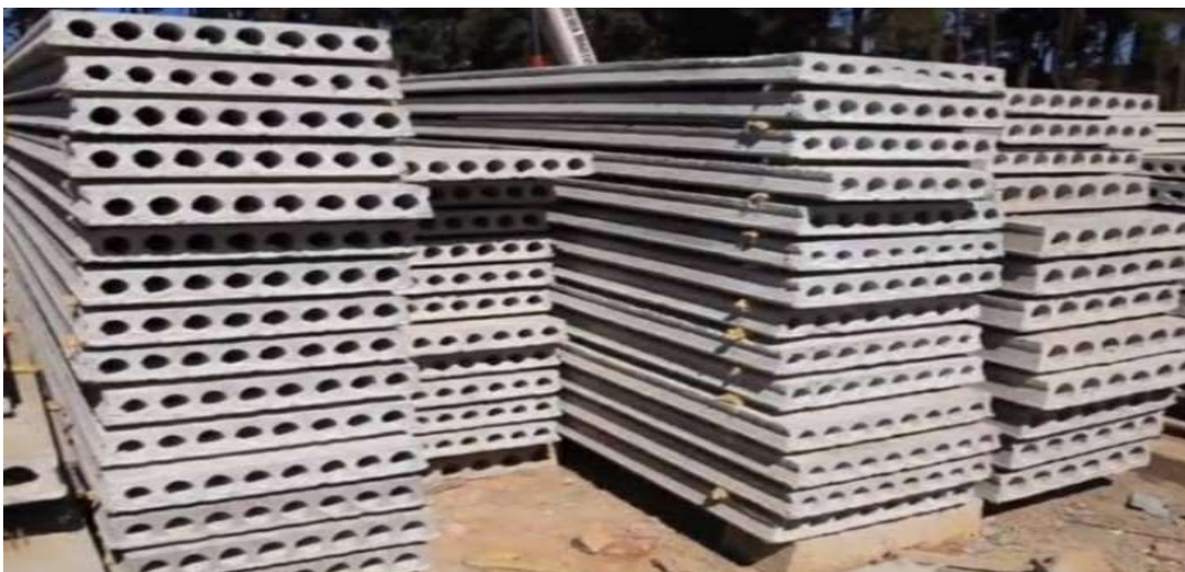
Figura 8 : Laje alveolar no canteiro de obras.
