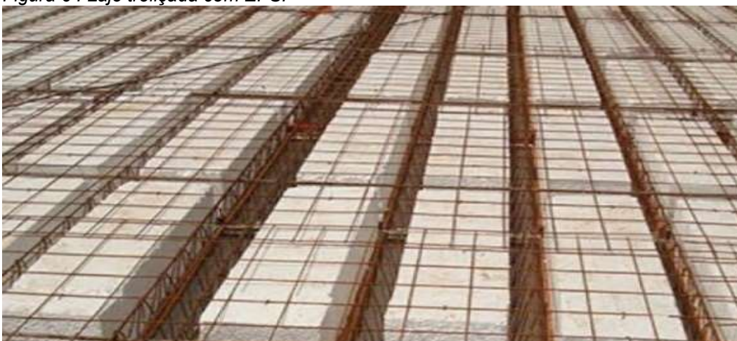
Figura 6 : Laje treliçada com EPS.
