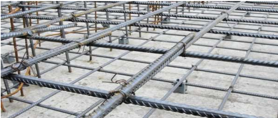
Figura 3: Armadura da laje
