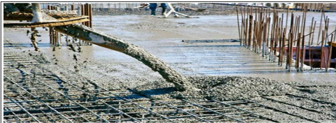
Figura 2: Concretagem de uma laje armada nas duas direções.
