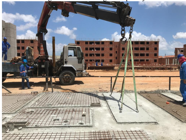
Figura 13: Desmoldagem da pré-laje
