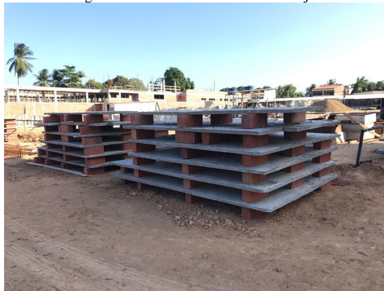
Figura 14: Armazenamento das Pré-Lajes
