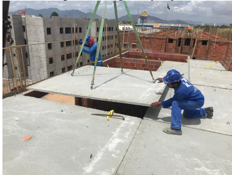
Figura 15: Montagem das pré-lajes
