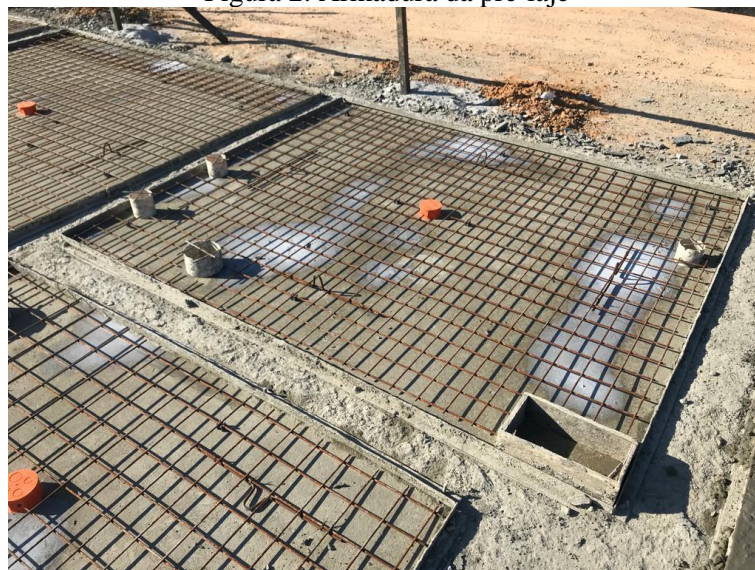
Figura 2: Armadura da pré-laje
