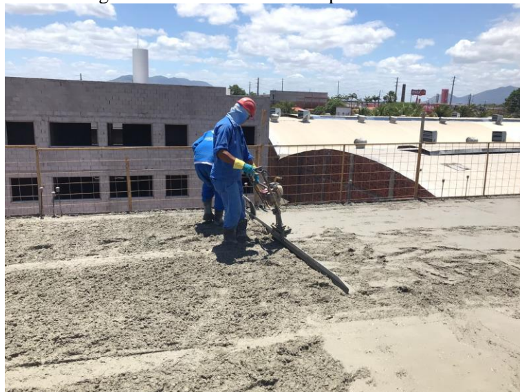
Figura 11: Adensamento da capa do concreto
