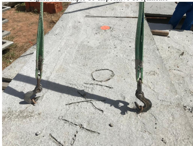
Figura 7: Exemplo do dispositivo de içamento
