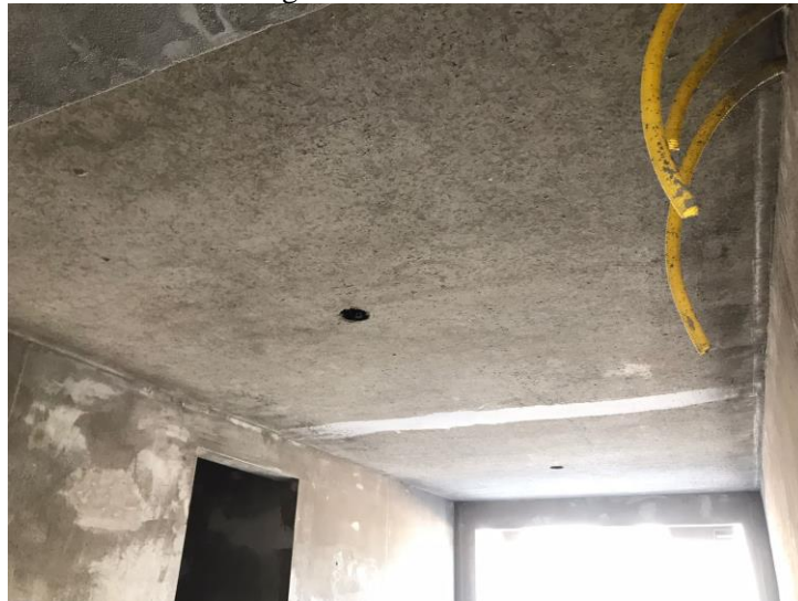
Figura 16: Teto da Sala
