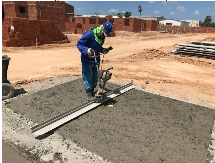
Figura 10: Adensamento da Pré-Laje
