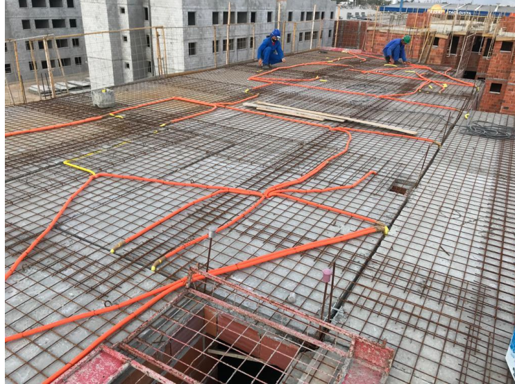
Figura 6: Exemplo da instalação das tubulações elétricas
