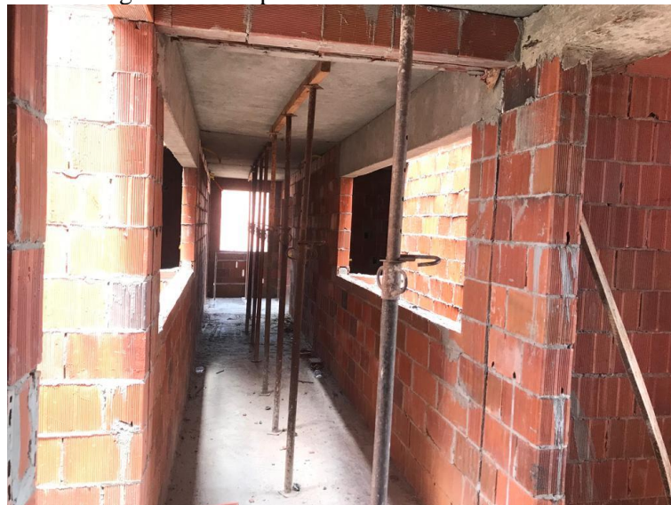
Figura 9: Exemplo de escoramento do corredor
