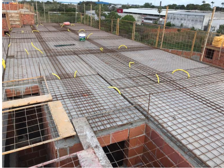
Figura 5: Armadura do capeamento
