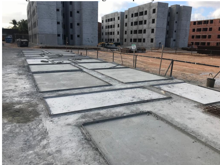
Figura 1: Pista de montagem das pré-lajes
