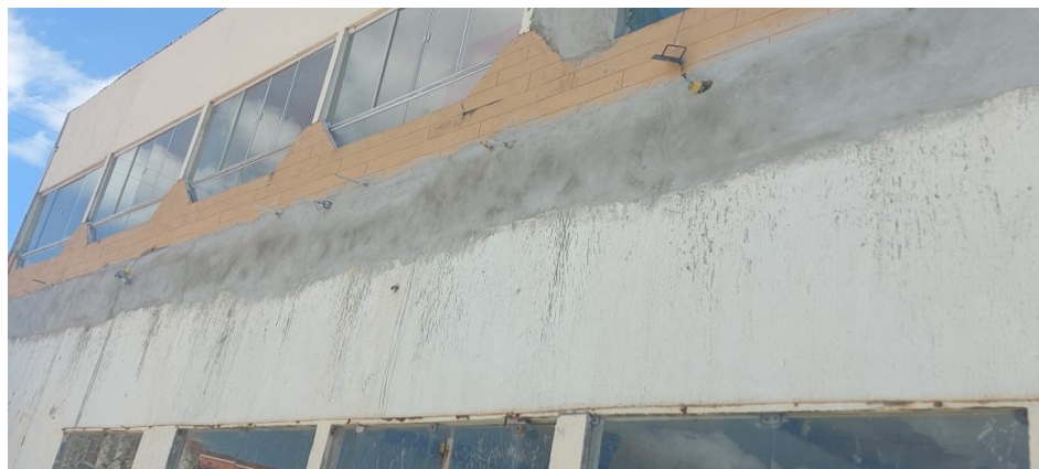
Figura 15. Viga restaurada na parte externa da pousada
