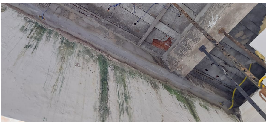
Figura 12. Viga restaurada, parte interna
