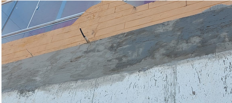
Figura 14. Aplicação de impermeabilizante
