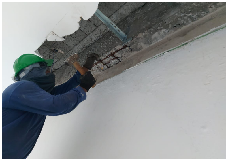
Figura 9. Escareação do concreto
