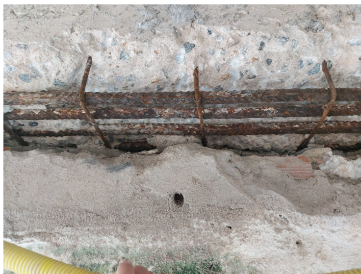
Figura 10. Pós escareação do concreto
