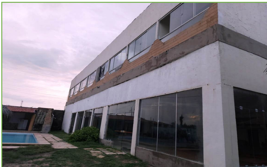
Figura 3. Fachada decorativa sob a viga o qual foi realizado o estudo. (fachada antes da recuperação)
