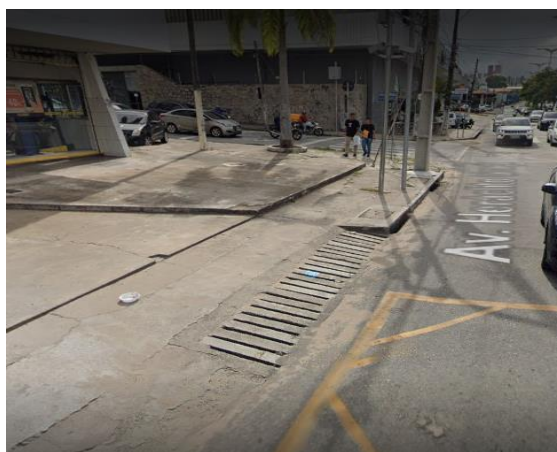
FIGURA 4 – Bueiros Av. Heráclito Graça
