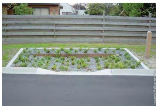
FIGURA 14 – Sistema de infiltração em Melbourne, Austrália. Disponível em: Kit de Treinamento Switch
