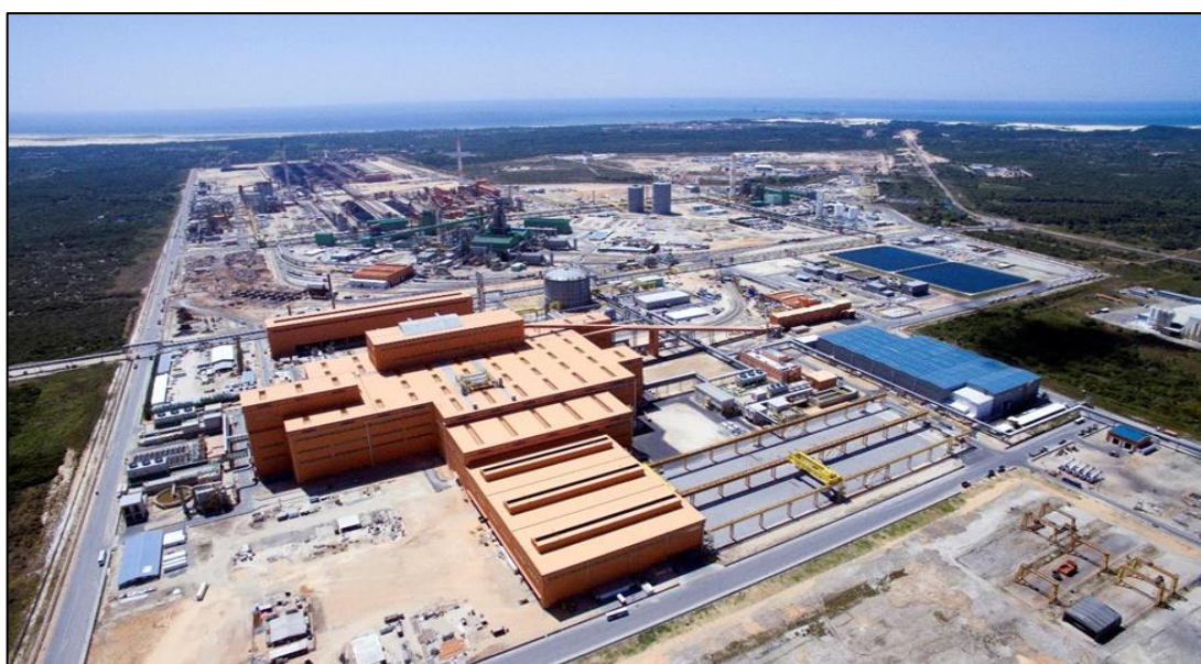
Figura 2-Vista geral de uma planta Siderúrgica
