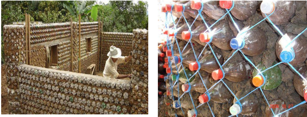
Figura 13 – Alvenaria com utilização de tijolo-garrafa
