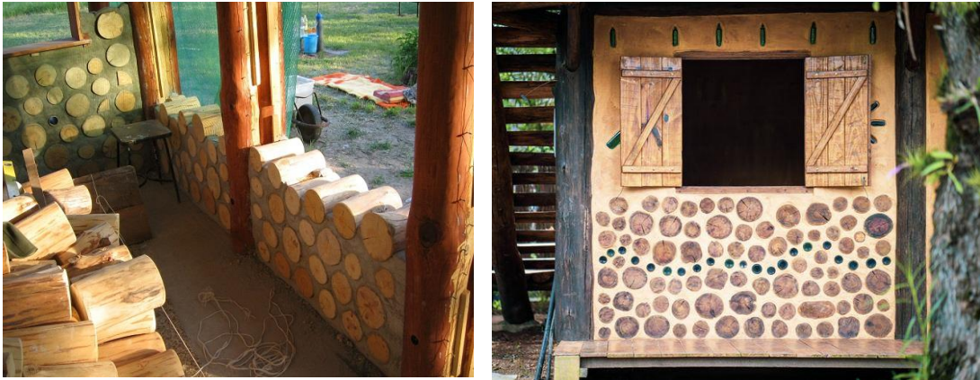
Figura 9 – Alvenaria de troncos de madeira construída pela Técnica Cordwood
