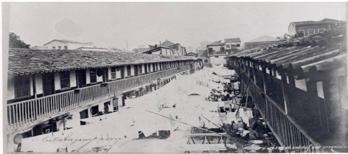
Figura 1 - Estalagem existente nos fundos dos prédios - Cortiços
