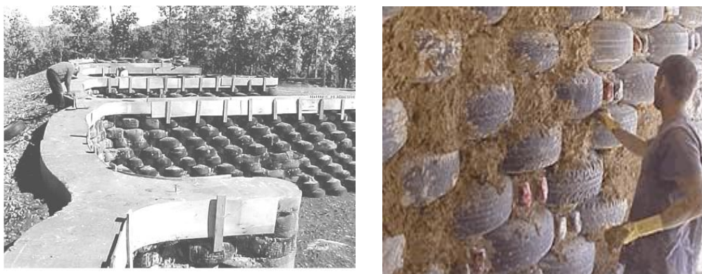
Figura 11 – Alvenaria feita com parede-pneu
