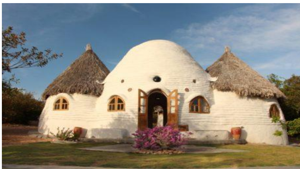
Figura 6 – Construção com uso de terra ensacada
