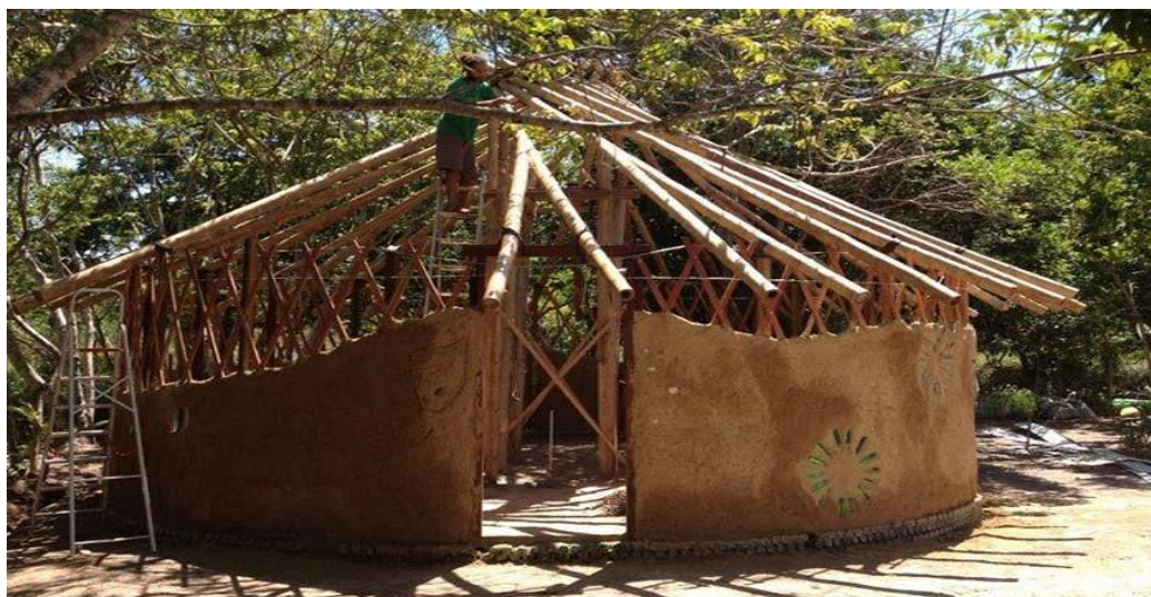
Figura 7 – Construção com estrutura de madeira e a massa de COB
