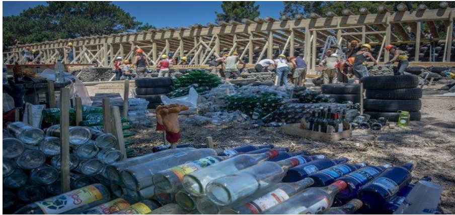
Figura 17 – Uso de materiais reciclados para construção da escola
