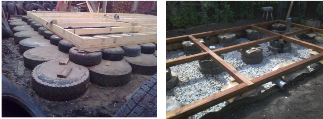
Figura 12 – Fundação feita com pneus velhos
