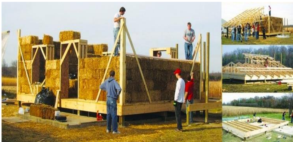
Figura 10 – Vedação e isolamento com fardos de palha
